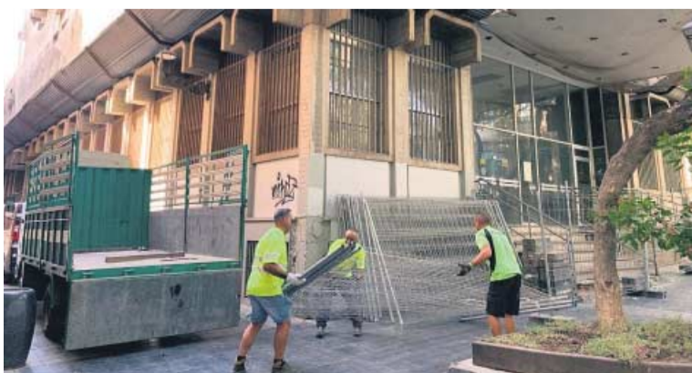
Los operarios desplegaron ayer el vallado perimetral del inmueble del centro.
